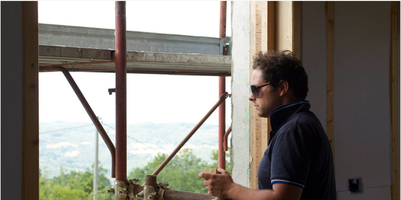
Il progetto prende forma attraverso il lavoro in cantiere.
