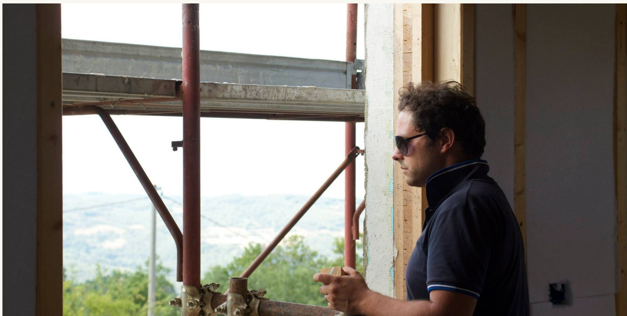
Le projet prend forme sur le chantier.
